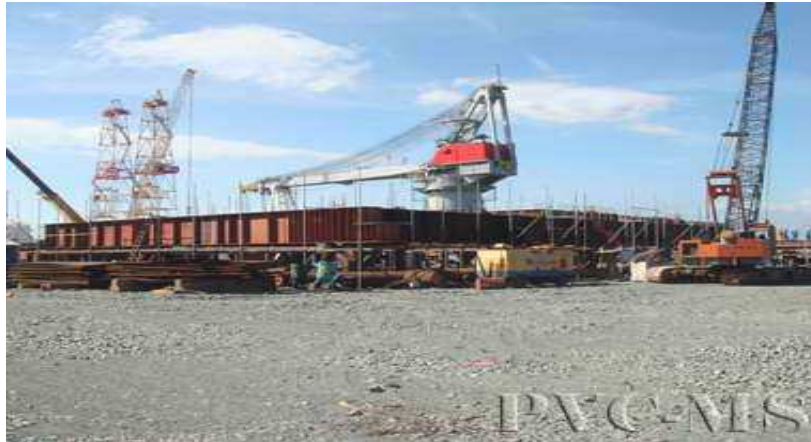
Hình ảnh: Chế tạo dầm chịu lực RP2 Chủ đầu tư: Vietsopetro
