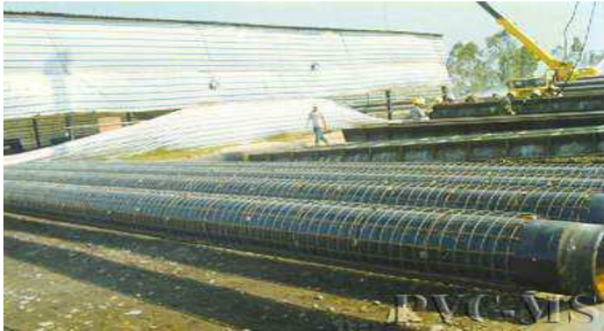
Hình ảnh: Bọc ống dẫn khí Bà Rịa – Phú Mỹ Chủ đầu tư: Tổng Công ty Khí Việt Nam
